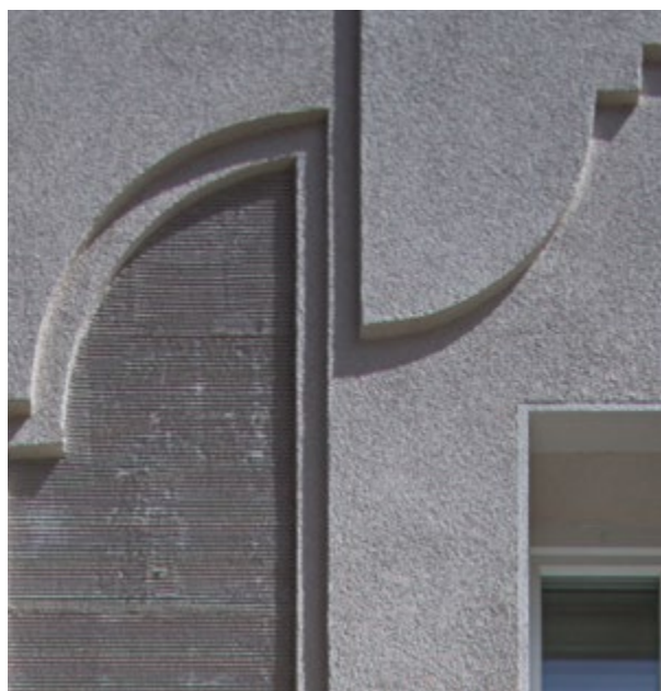
Bei dieser Fassade mit WDVS wurden Putzornamente aufgebracht.
