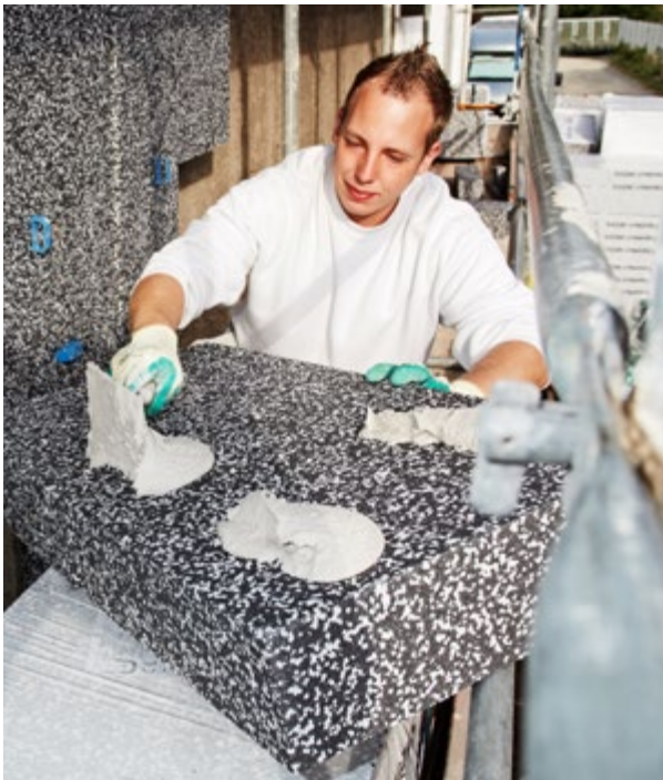
Anbringung einer Polystyrolplatte.
