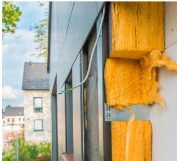
Hinterlüftete Fassade mit Mineralwolldämmung.
