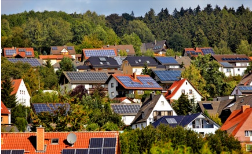
Alle geeigneten Dachflächen voll auszunutzen, ist bei der Photovoltaik die beste Option – sowohl fürs Klima als auch für den Geldbeutel der Anlagenbetreiber.
