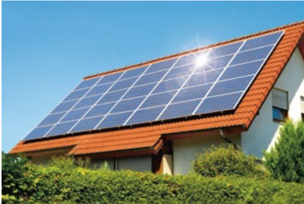
Überschüssiger Solarstrom kann Wasser erwärmen.
