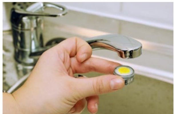
Ein Spar-Strahlregler verringert den Verbrauch um bis zu 30 Prozent.
