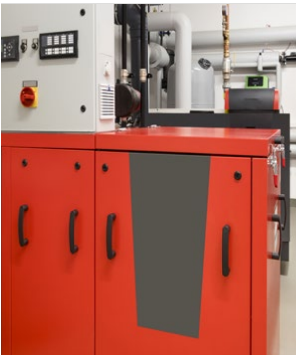
In Ihrem Heizungskeller können Sie mit einem kleinen Blockheizkraftwerk auch Ihren eigenen Strom erzeugen.
