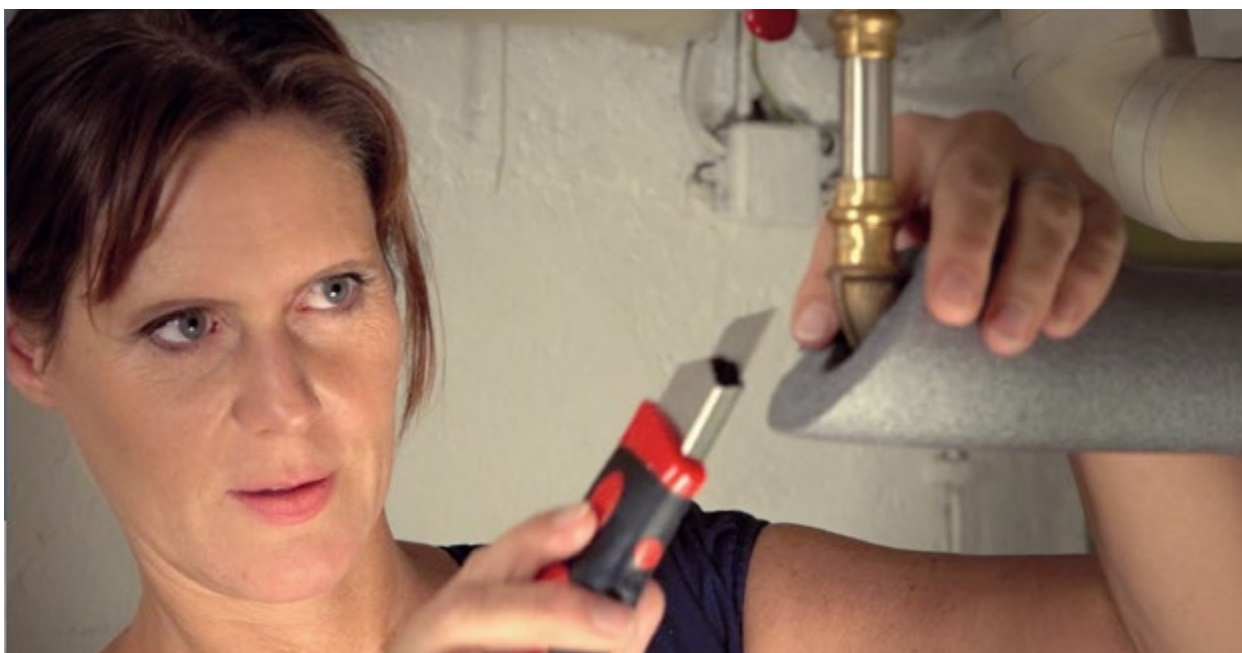
Ihre Heizungsrohre können Sie ganz einfach selbst dämmen. Die Arbeit macht sich schnell bezahlt.
