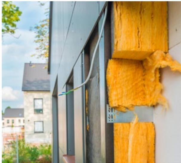
Hinterlüftete Fassade mit Mineralwolldämmung.
