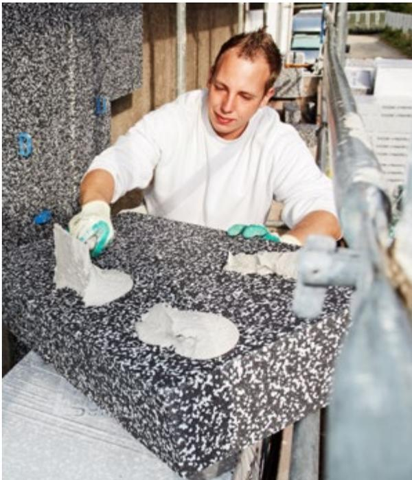
Anbringung einer Polystyrolplatte.
