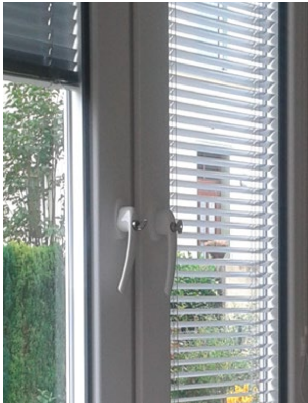
Abschließbare Fenstergriffe lassen sich einfach nachträglich anbringen.
